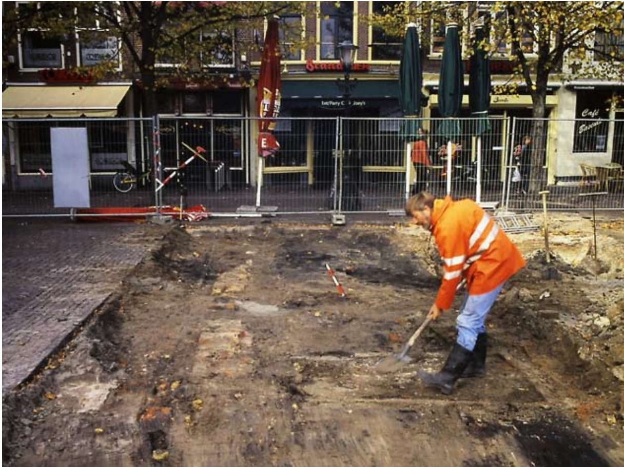
Graafwerk aan kelder 6B, met links de fundering 5/6X (vanuit het oosten)
