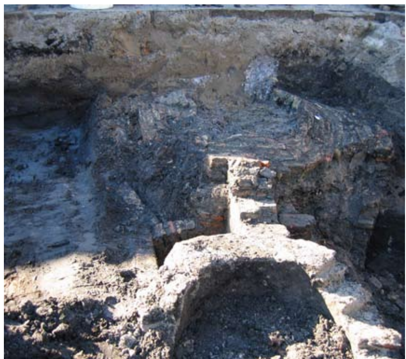
Waterput 5/6ZA, een bakstenen bovenstuk op twee gestapelde wijntonnen, was secundair als beerput gebruikt. Rechts is te zien dat naderhand beerput 6C er tegenaan is gebouwd (met koepel, op de achtergrond, vanuit het zuiden gezien)
